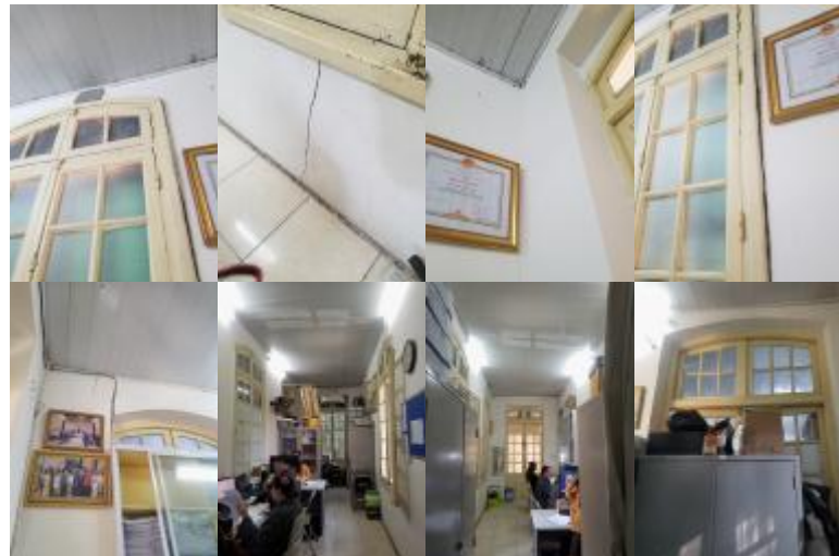
PHÒNG 22: - XUẤT HIỆN VẾT NÚT Ở TƯỜNG PHÍA TRÊN CỬA, NÚT BẦU CỬA SỐ, NÚT PHÂN GỐC TƯỜNG, VÁCH TƯỜNG - CỬA ĐI LẠI, CỬA SỐ XẬP XẼ, BONG CHỐC SƠN - TRẦN NHỰA VỠ BONG CHỐC
