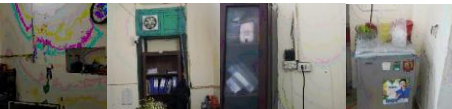
PHÒNG 03: CỬA SỔ VÀ CỬA ĐI ĐÃ XUỐNG CẤP, BONG KHUÔN VÀ TRóc SƠN. TRẦN NHỰA MỤC VỠ. TƯỜNG NỨT VỠ, BONG SƠN, ẨM MỐC. Ổ ĐIỆN MẤT NÁP AN TOÀN
