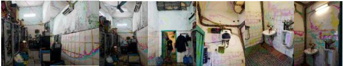
PHÒNG KHO 02: GẠCH ỐP TƯỜNG BỊ Ồ VẮNG, TƯỜNG BỊ BONG TRÓC, NÚT VỠ. SƠN ẨM MÀU, ẨM MỐC TRẦN NHỰA MỤC VỠ, KHUNG CỬA HAN RỈ, KÍNH Ồ ĐỤC
