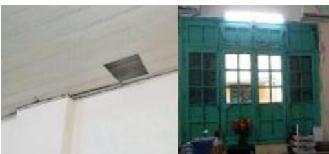
PHÒNG 02: CỬA SỔ VÀ CỬA ĐI ĐÃ XUỐNG CẤP, BONG KHUÔN VÀ TRóc SƠN. TRẦN NHỰA MỤC VỠ. TƯỜNG SƠN ẨM MÀU, Có NHIỀU VỆT XƯỚC ĐEN
