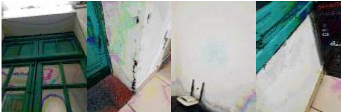
PHÒNG 07: CỬA SỔ VÀ CỬA ĐI ĐÃ XUỐNG CẤP, BONG KHUÔN VÀ TRÓC SƠN. TRẦN NHỰA MỤC VỠ. TƯỜNG SƠN ẨM MÀU, CÓ NHIỀU VẾT XƯỚC ĐEN
