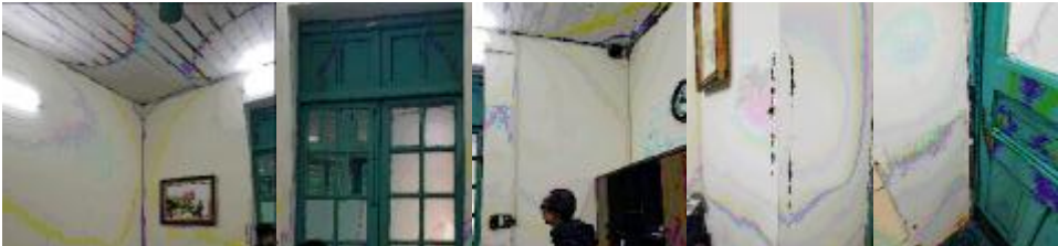
PHÒNG 08: CỬA SỔ VÀ CỬA ĐI ĐÃ XUỐNG CẤP, BONG KHUÔN VÀ TRÓC SƠN. TRẦN NHỰA MỤC VỠ. TƯỜNG SƠN ẨM MÀU, CÓ NHIỀU VẾT XƯỚC ĐEN
