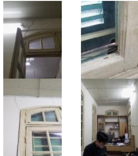
PHÒNG 20: - XUẤT HIỆN VẾT NÚT Ở TƯỜNG PHÍA TRÊN CỬA, VÁCH TƯỜNG - CỬA ĐI LẠI, CỬA SỐ XẬP XẼ, BONG CHỐC SƠN - TRẦN BONG CHỐC SƠN
