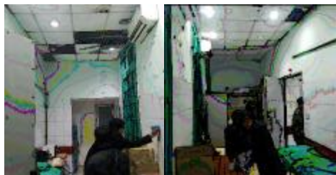
PHÒNG KHO: CỬA SỔ VÀ CỬA ĐI ĐÃ XUỐNG CẤP. TRẦN NHỰA ĐÃ VỠ, GẦY. TƯỜNG NỨT VỠ, BONG SƠN, ẨM MỐC.
