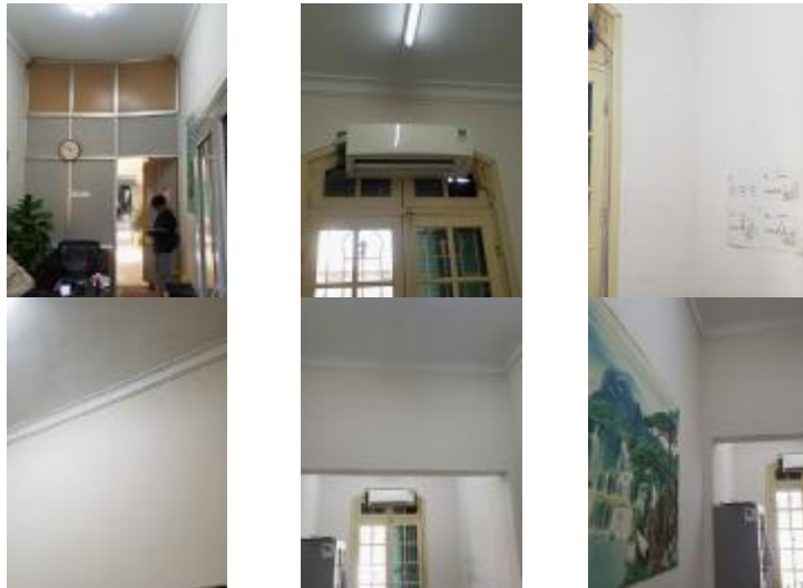
PHÒNG 19: - XUẤT HIỆN VẾT NÚT Ở TƯỜNG, PHÍA TRÊN CỬA SỐ, PHẪO TRẦN, VỊ TRÍ TIẾP GIÁP TƯỜNG VỚI CỘT - CỬA ĐI LẠI, CỬA SỐ XẬP XẼ XUỐNG CẤP, BONG CHỐC SƠN
