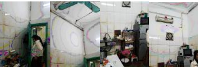
PHÒNG BẾP 02: GẠCH ỐP TƯỜNG BỊ Ồ VẮNG, TƯỜNG BỊ BONG TRÓC, NÚT VỠ. SƠN ẨM MÀU, ẨM MỐC CỬA ĐI TRÓC SƠN, HỒNG KHUÔN
