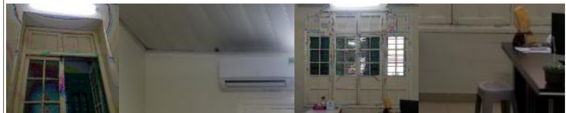
PHÒNG 01: CỬA SỔ VÀ CỬA ĐI ĐÃ XUỐNG CẤP, BONG KHUÔN VÀ TRóc SƠN. TRẦN NHỰA MỤC VỠ. TƯỜNG SƠN ẨM MÀU, Có NHIỀU VỆT XƯỚC ĐEN
